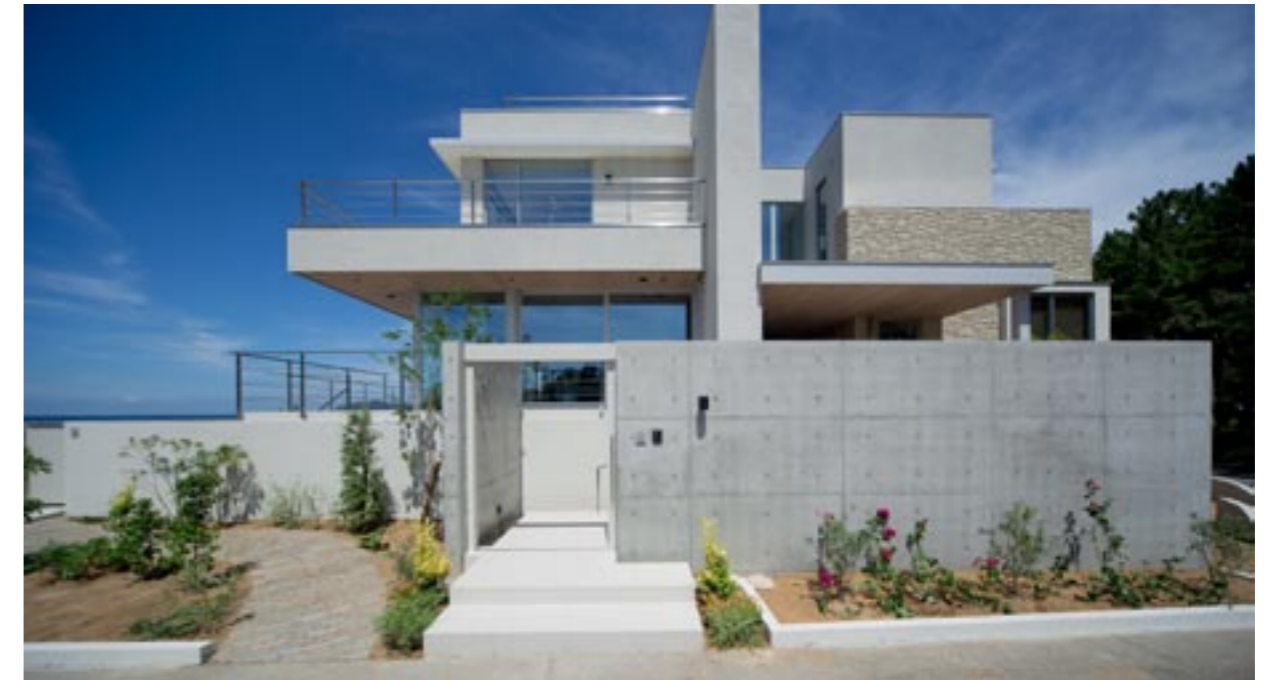
同左/エントランス
