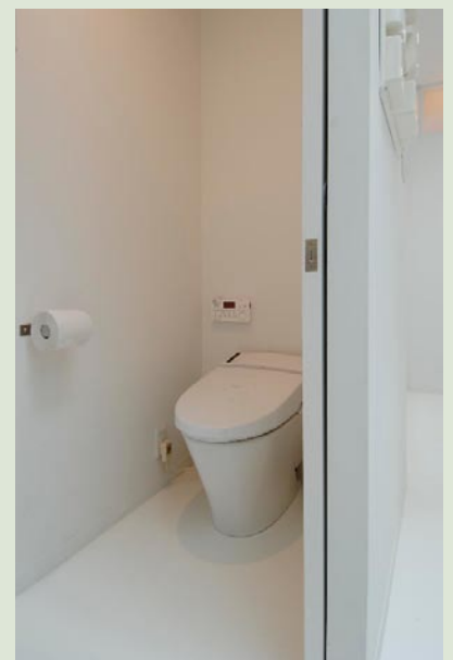
エコな暮らしを支える超節水ECO6搭載のサティス。洗浄水量は旧来型の13ℓから6ℓへ。ここではコレクションのイスのひとつのような美しいフォルムも魅力だ
