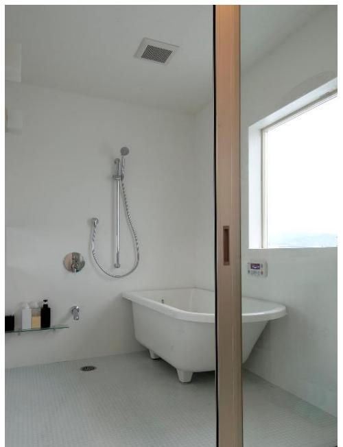
2階に置かれた浴室。写真手前に見える浴室の扉は外部用のサッシを流用。コストを抑えつつ、開放的な浴室を実現する
